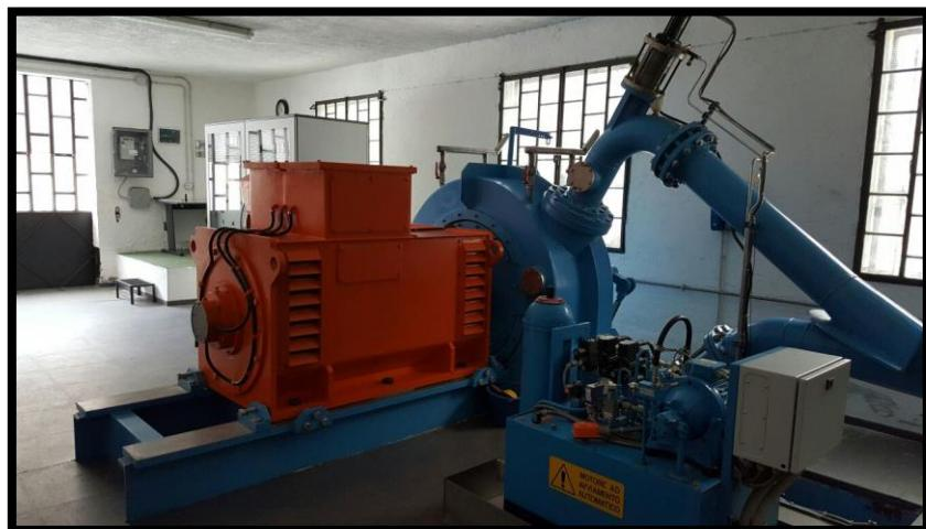
*Fig: turbina Pelton, nuovo impianto.*
