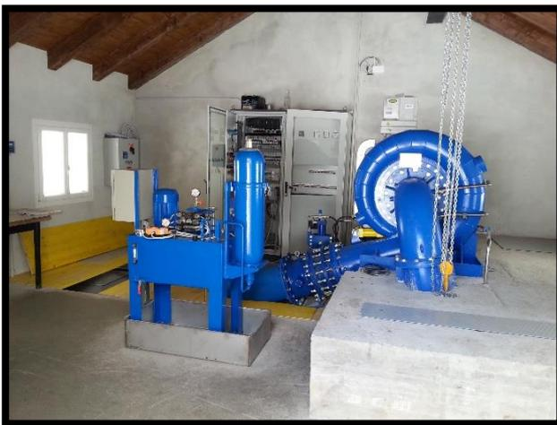
*Fig: gruppo idroelettrico basato su turbina Francis e condotta in PEAD impianto "Antoliva 2"*
