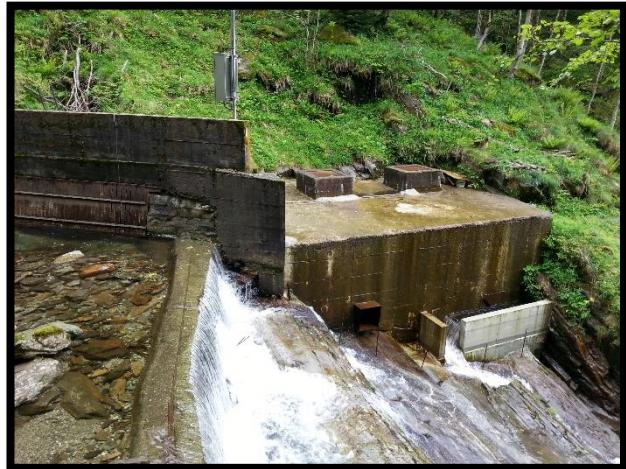
*Fig: muro di sbarramento e vasca di carico*
