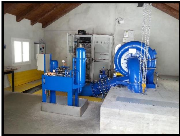
*Fig: gruppo idroelettrico basato su turbina Francis e condotta in PEAD impianto "Antoliva 2"*
