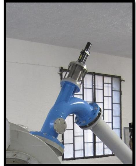
Con gli interventi effettuati nel 2012 è stata posta una sonda a monte dell'impianto di produzione in grado di rilevare il livello dell'acqua nel bacino di carico e inviare le informazioni nella cabina di produzione dove, un sistema automatico, regola l'apertura della spina in modo solidale con la variazione della quota massima nel bacino di monte.
