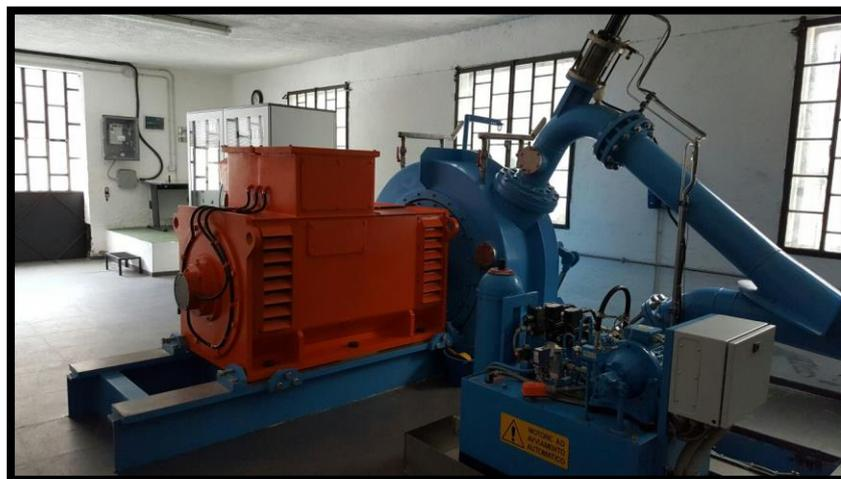
*Fig: turbina Pelton, nuovo impianto.*
